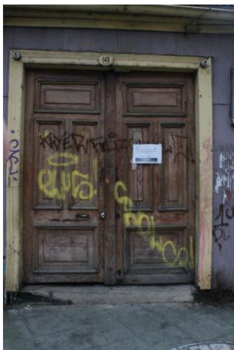
Hojas de la puerta principal de la Estación Superior del Ascensor Cordillera
